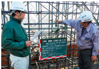
現場打ち枠の配筋検査
