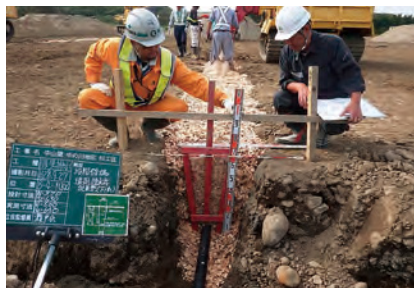
暗渠排水断面確認
