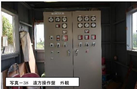
写真-38 遠方操作盤 外観
