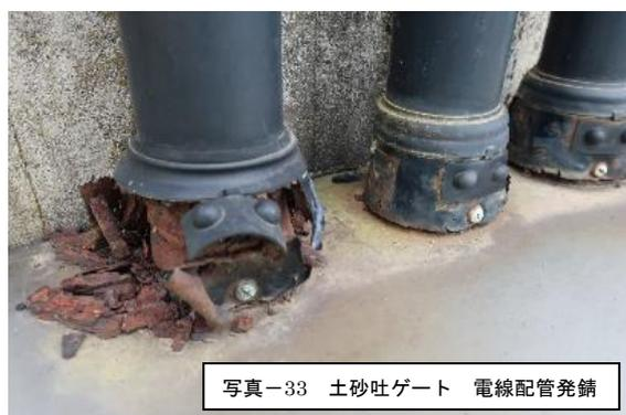
写真-33 土砂吐ゲート 電線配管発錆
