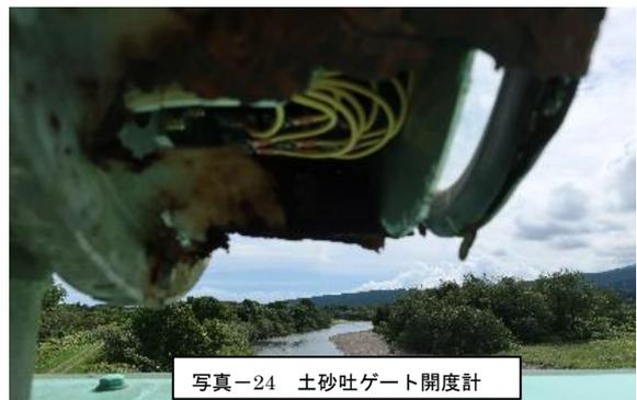
写真-24 土砂吐ゲート開度計
