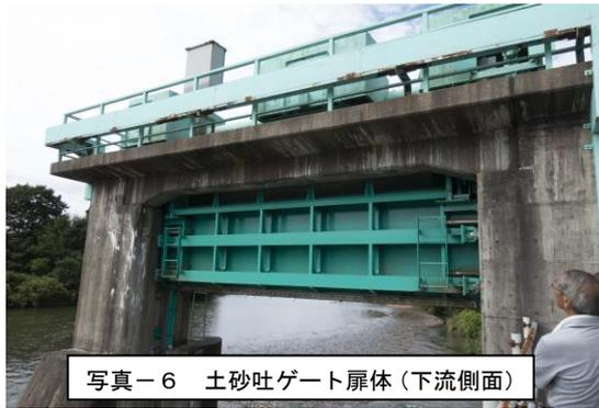
写真-6 土砂吐ゲート扉体（下流側面）
