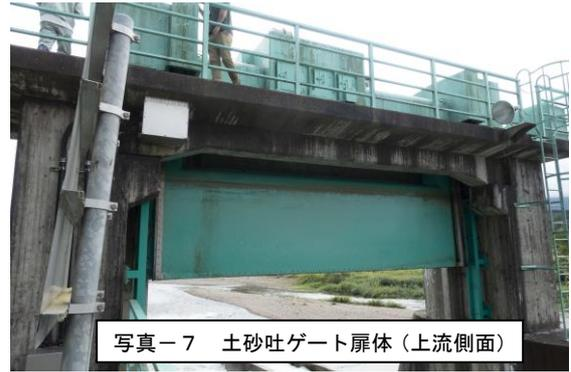
写真-7 土砂吐ゲート扉体（上流側面）
