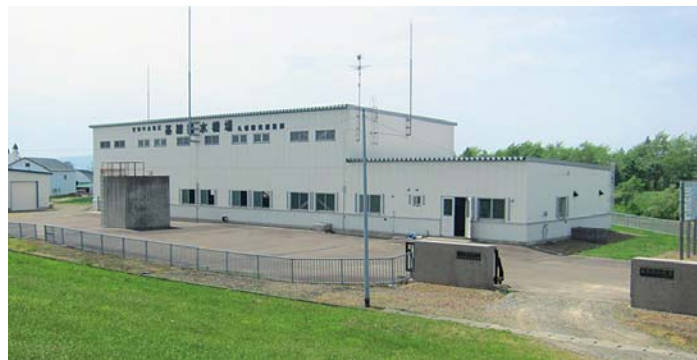
基線揚水機場
