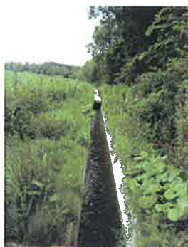
第5支線用水路
