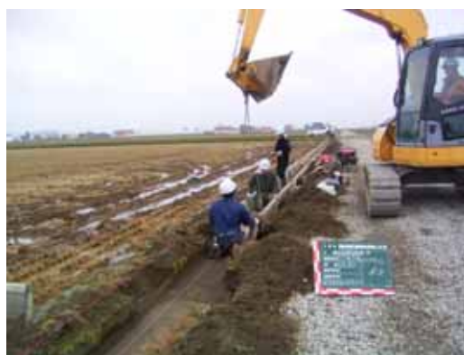
揚水機場の分解補修(左)、用水路のトラフ布設替え(右)に農業基盤整備資金を活用
