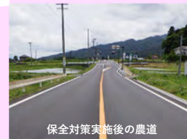
保全対策実施後の農道
