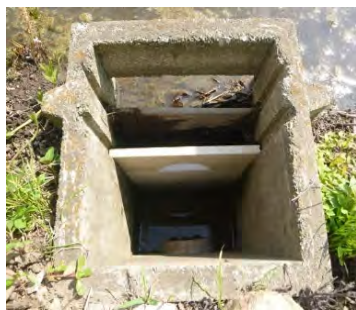
田んぼダムの取組例 (調整板の設置)
