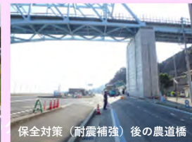
保全対策（耐震補強）後の農道橋
