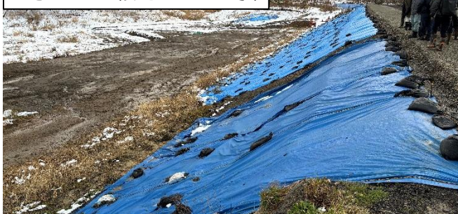
2号ため池（押さえ盛土工事）
