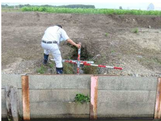
SP2,360(R)流入箇所 (柵板削孔・ 流入部掘削状況)
