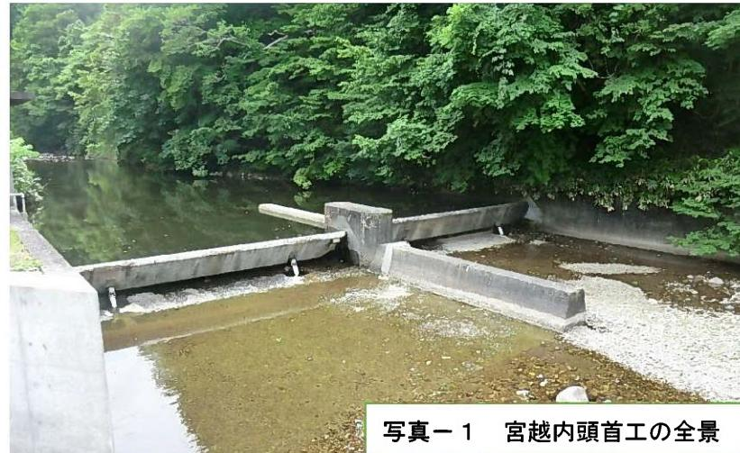
えん堤本体は、可動堰で油圧式起伏ゲートを採用しており、堰高0.9m、堰長固定部1m、堰長可動部1.8mで土砂吐、洪水吐それぞれ幅9m、高さ0.9mのゲートを1門ずつ据え付けられている。また、取水ゲートは、幅1m高さ0.8mのスルースゲート1門が据え付けられている。
