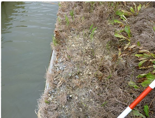
裏込砂利の現況(H23補修済で沈下は無い)
