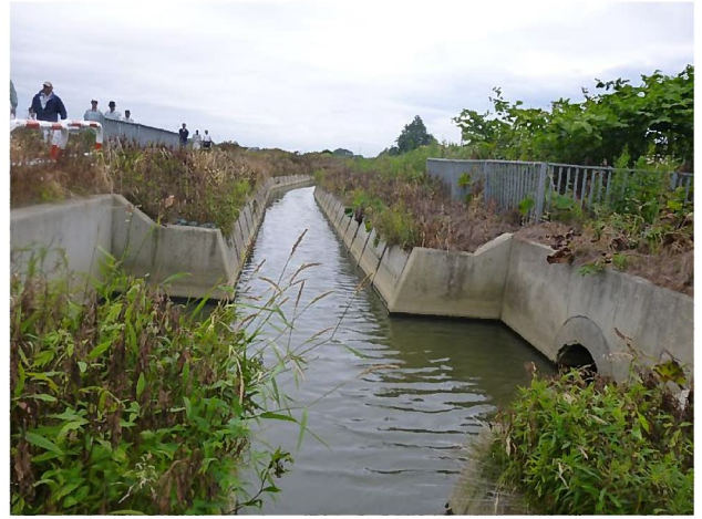
終点側より排水路全景
