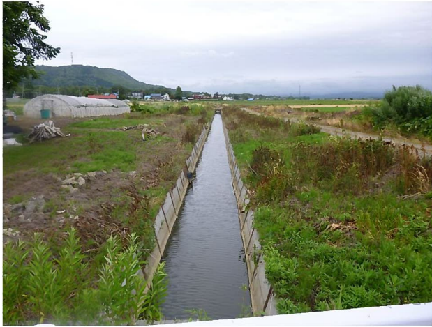
起点側より排水路全景
