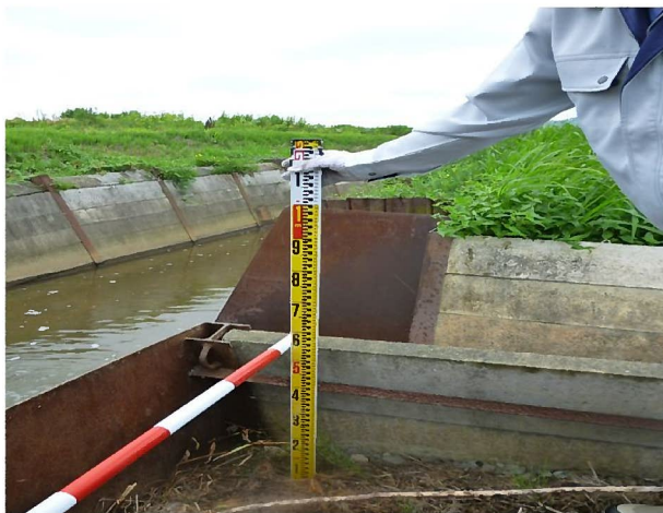
砂利の沈下状況(60cm程度)
