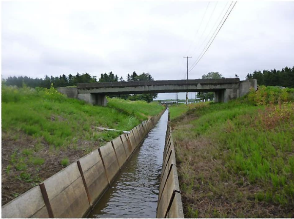
起点側より排水路全景
