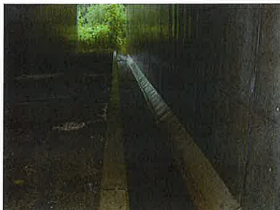
豊富バイパスのボックスカルバート内 本線排水路流下状況(上流から下流撮影)
