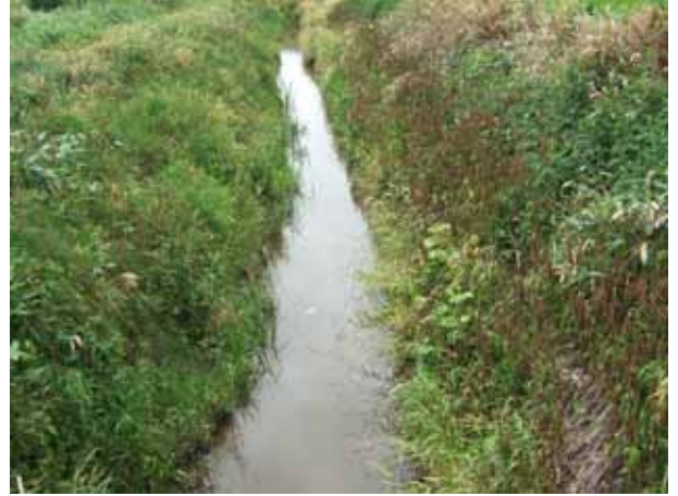
SP 5 0 0 付近 農地取付橋から下流方向
