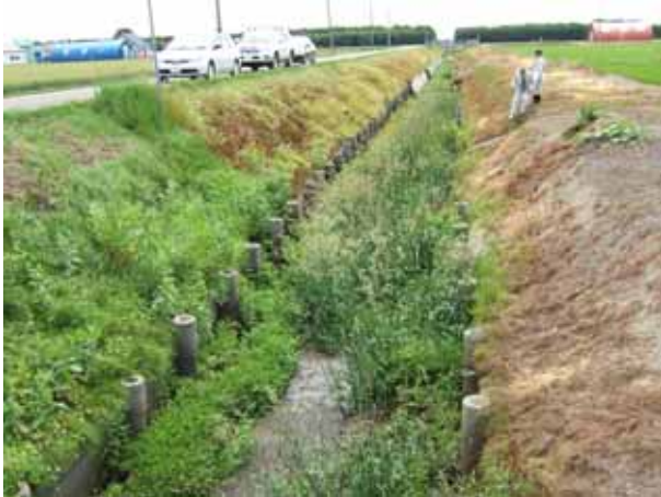
宅地取付橋から下流方向 コンクリート杭による建込柵渠
