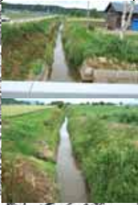
金沢幹線排水路
