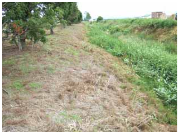
SP 3000 付近から下流方向の法のはらみ
