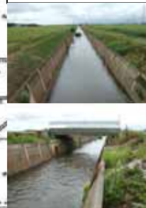
八幡25線排水路
