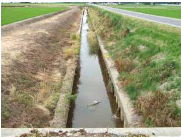
SP 3000 付近の町道橋から上流方向 鋼矢板施工区間
