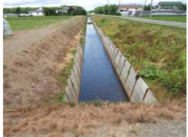
宅地取付橋から上流方向 の柵渠の状況
