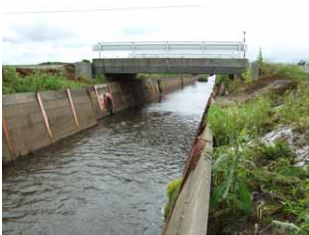
終点より 5 0 0 m 付近から下流方向
