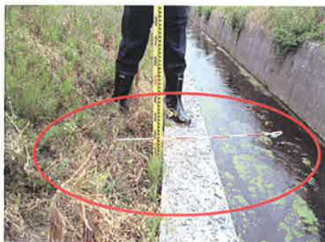
裏込状況、コンクリート劣化状況
