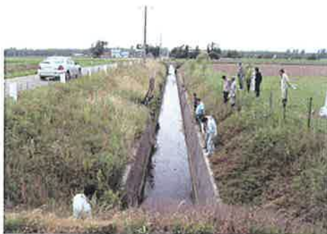
裏込状況、コンクリート劣化状況
