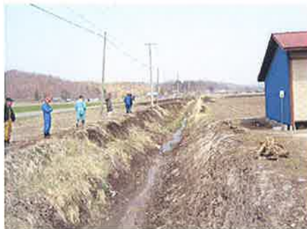
第1幹線用水路
