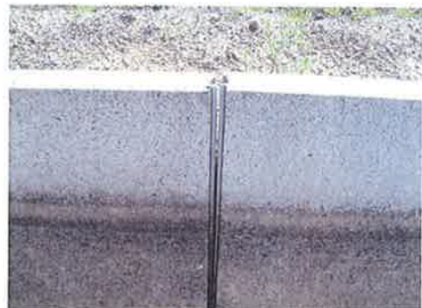
目地状況 （一部）→
