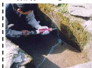
水路のひび割れ補修
